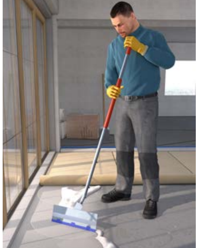
Abb. 20 Aufrechte Körperhaltung durch Einsatz von Teleskopstiel
