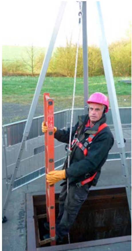
Abb. 3 PSA gegen Absturz (Dreibein als Anschlageneinrichtung, Auffanggurt und Seil einschließlich mitlaufendes Auffanggerät)
