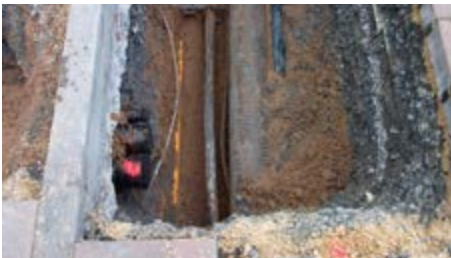
Abb. 7 Baugrube mit Fremdanlagen
