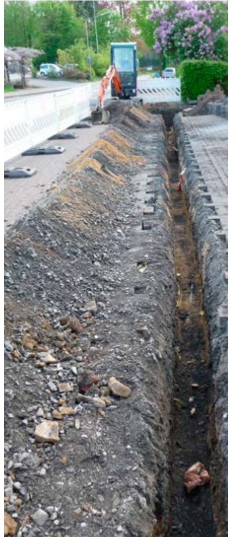
Abb. 12 Sicherung der Arbeitsstelle 1
