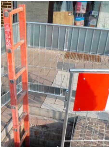
Abb. 6 Eintrittsstelle mit Steigleiter
