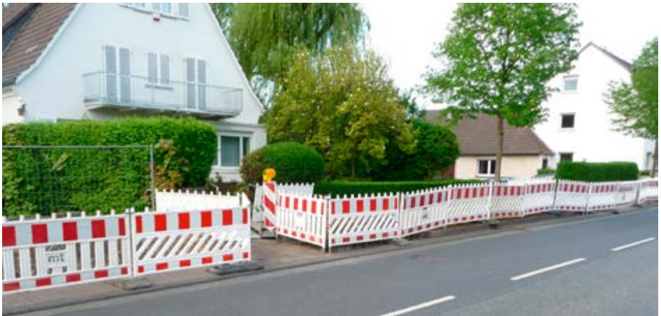
Abb. 13 Sicherung der Arbeitsstelle 2
