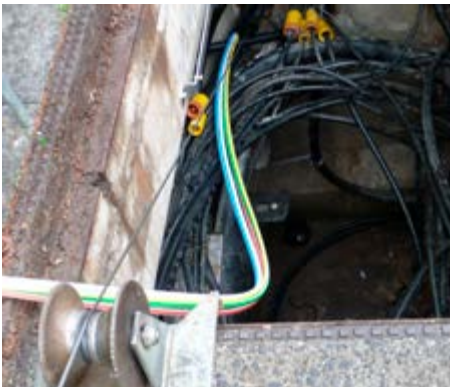
Abb. 10 Kabelzieharbeiten
