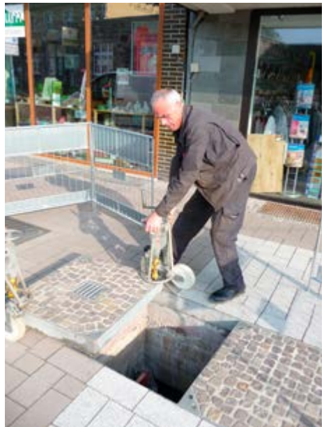
Abb. 9 Öffnen eines Kabelschachtes
