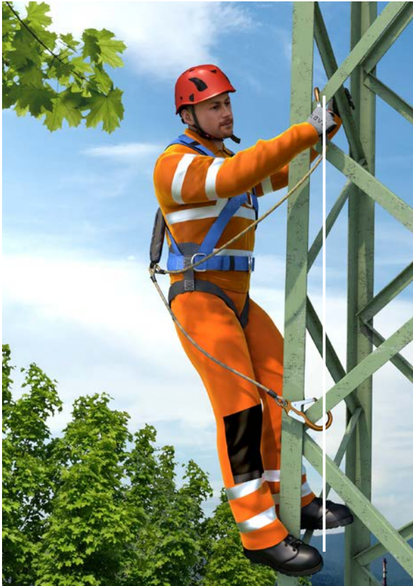
Abb. 5.3.12 Besteigung eines Mastes unter Anwendung der Y-Seil-Methode
