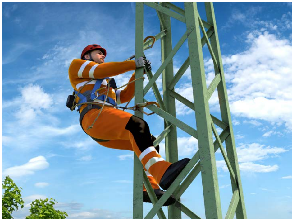
Abb. 5.4 1 Beispiel für die Haltefunktion
