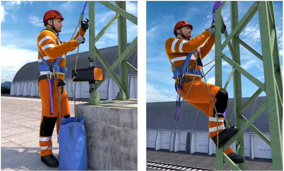
Abb. 5.3.2 1 Besteigung eines Mastes unter Anwendung der Schlaufenmethode
