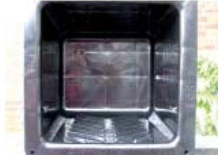
Bild 7: Steigkasten ohne Festhaltungsmöglichkeit
