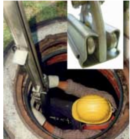
Bild 9: Steigleiter mit Mittelholm, Steigschutzeinrichtung und steckbarer Haltevorrichtung
