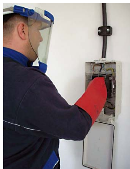
PSA beim Ziehen einer NH-Sicherung
