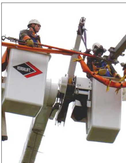
Arbeiten mit Isolierhandschuhen an einem 20-kV-Abspannmast
