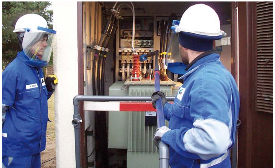
Arbeiten auf Abstand beim Reinigen einer 20-kV-MS-Anlage
