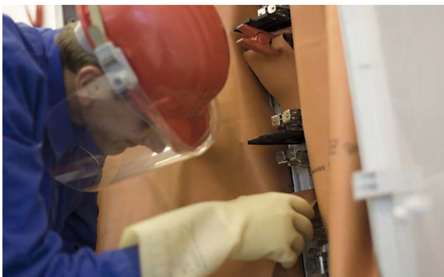
Arbeiten mit Isolierhandschuhen an einer NS-Schaltanlage
