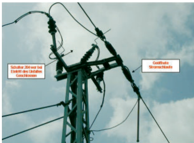
Abbildung 4: Schalter 204 war bei Eintritt des Unfalles geschlossen.
