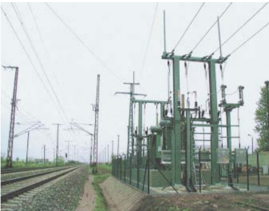
Bild 2: Autotransformer-Kuppelstelle Anklam
