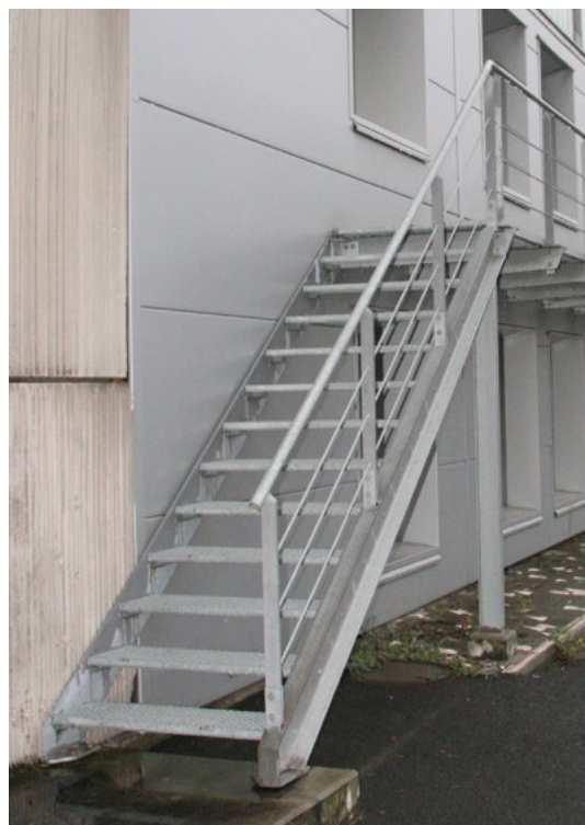
Abbildung 2: Auch für im Freien liegende Treppen gelten die Anforderungen nach der ASR A1.8
