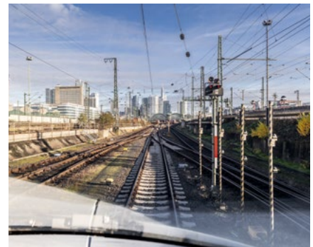
Einfahrt in Frankfurt am Main – Bereitstellungsfahrt – Blick aus dem Führerraum
