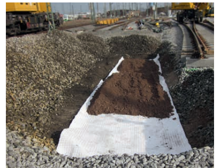
Einbau einer Planumsschutzschicht auf Geoverbundstoff für Rigole auf der VDE8.
