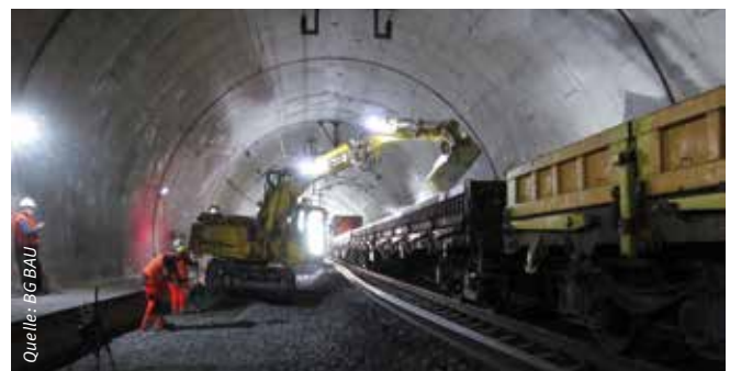
Gleisbauarbeiten im Tunnel
