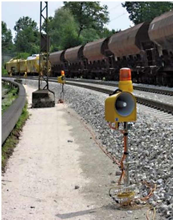
Abbildung 4: Kabelgestütztes AWS der Fa. Schweizer, Reiden
