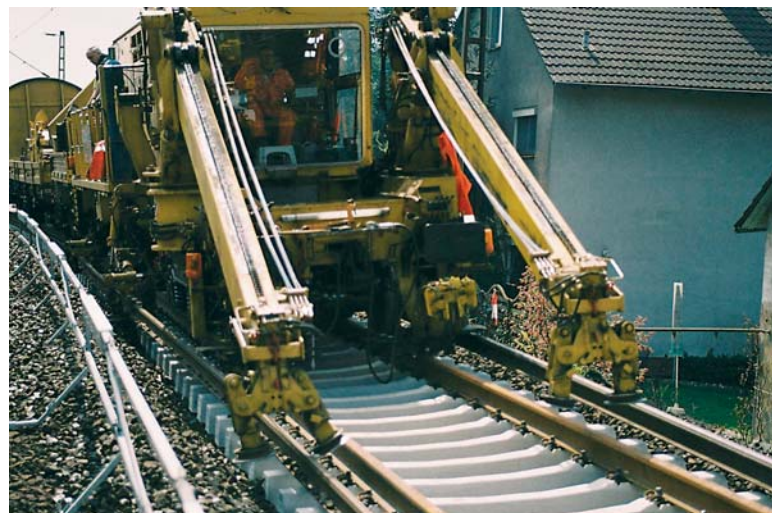
Abbildung 8, oben: Linienwarmsystem FALKON bei 4,00 m Gleisabstand, Gleisumbau im Bogen.
