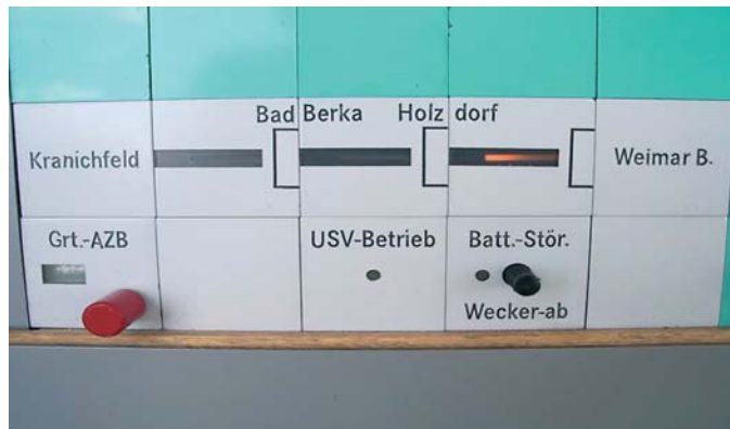
Abbildung 4: Stellpult mit Elementen für AU ZLB beim ZL in Weimar Berkaer Bf.
