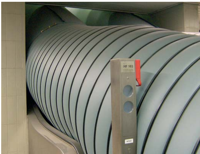
Abbildung 5: Mit Metallringen verstärkte Lutten.
