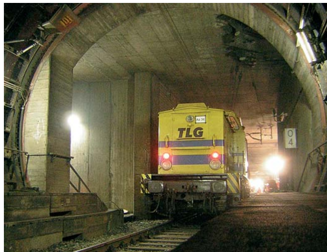
Abbildung 9: Eine von sechs Loks, die im Tunnel zum Einsatz kamen.
