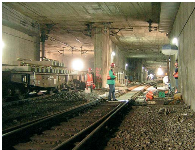
Abbildung 6: Beleuchtung der Tunnelbaustelle.
