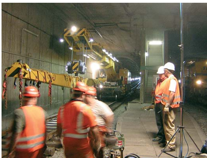
Abbildung 10: Im Tunnel eingesetzter Kran.
