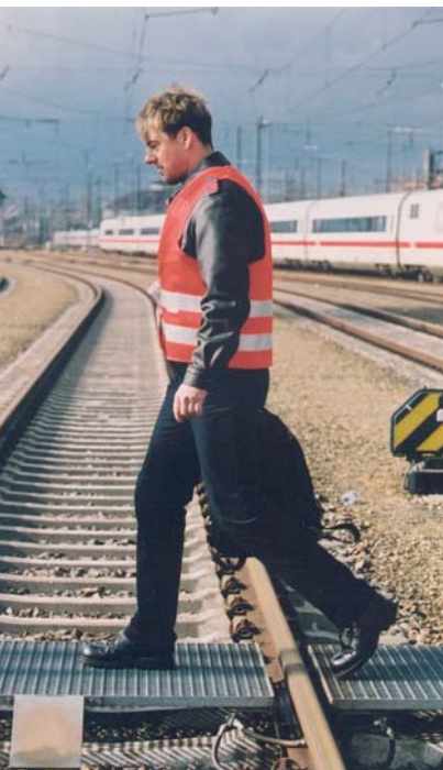
Abbildung 2: Gleisübergang mit Metallgitterrosten.
