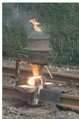
Abbildung 2, rechts: Überflüssiges Metall und Schlacke füllen die Schlackeschalen. Das Metall ist immer noch ca. 900° C heiß.
