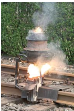
Abbildung 2, rechts: Überflüssiges Metall und Schlacke füllen die Schlackeschalen. Das Metall ist immer noch ca. 900° C heiß.
