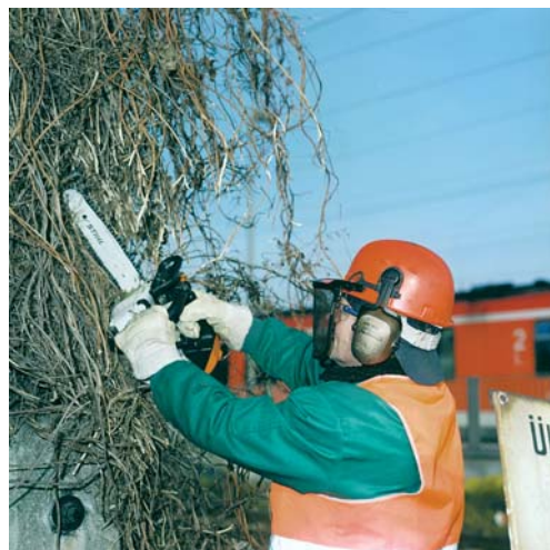
Abbildung 6: Arbeiten mit der Motorsäge nur mit Befähigung und geeigneter PSA. Foto: DB AG/ Bedeschinski.
