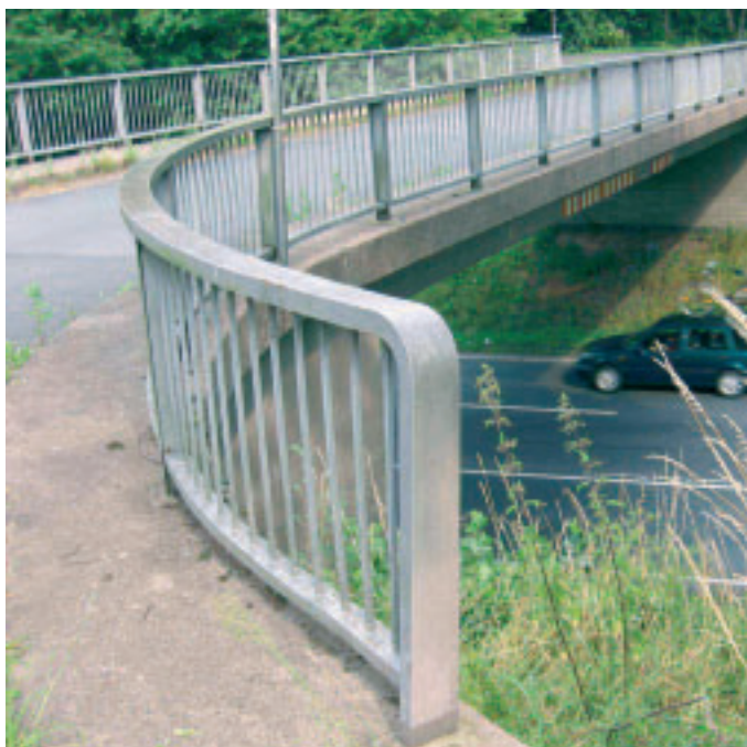
Abbildung 3: Gefahr von überfrierender Nässe ist auf Brücken besonders groß.
