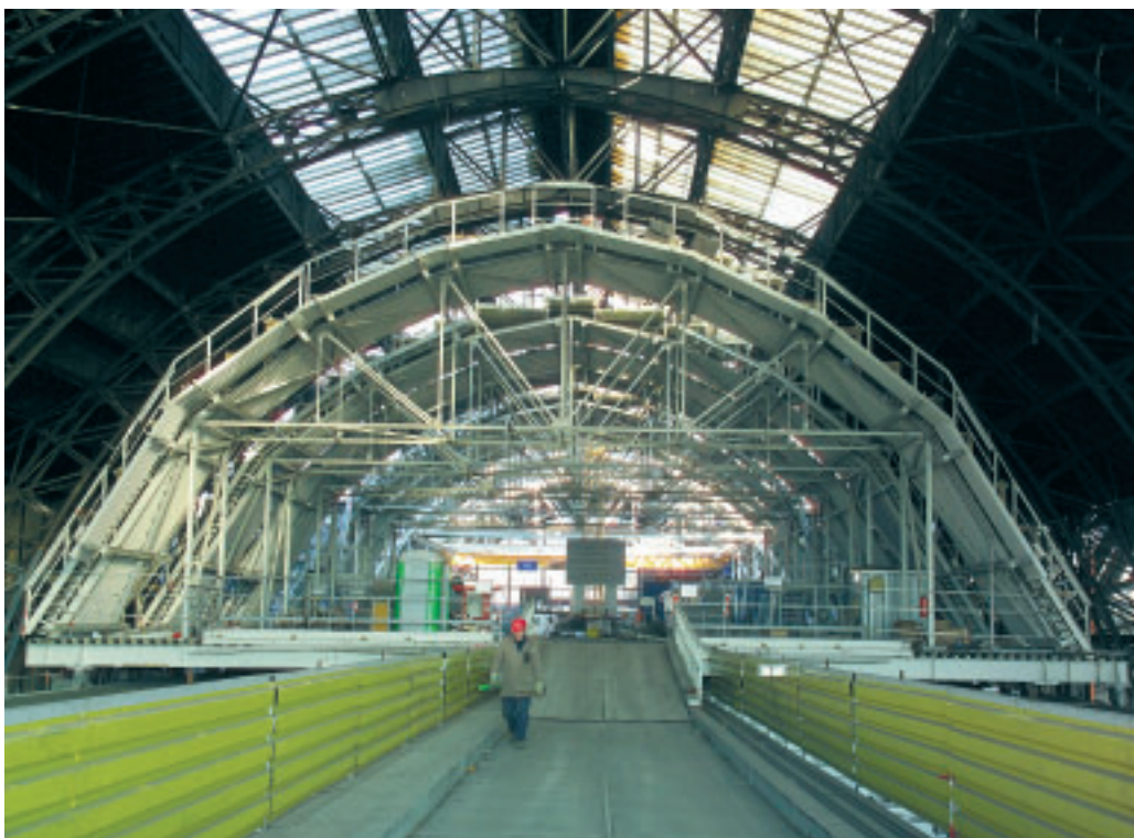
Arbeitsplattform mit Montagegerüst.
