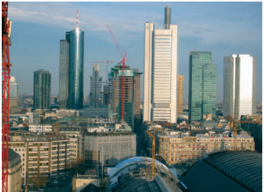
Blick von der Baustelle auf die Innenstadt.
