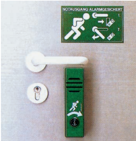
Bild 6: Türwächter Diese Ausführung erfordert zwei Handgriffe. Deswegen Türwächter unter Bild 5 zu empfehlen.
