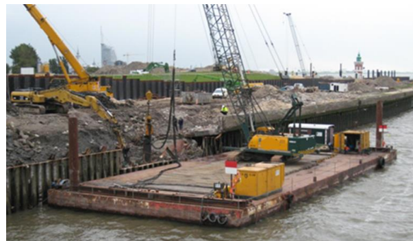
Abb. 1: Auf einem Ponton als mobiles, zeitweise angeordnetes Arbeitsmittel verwendeter Seilbagger (Fall A)
