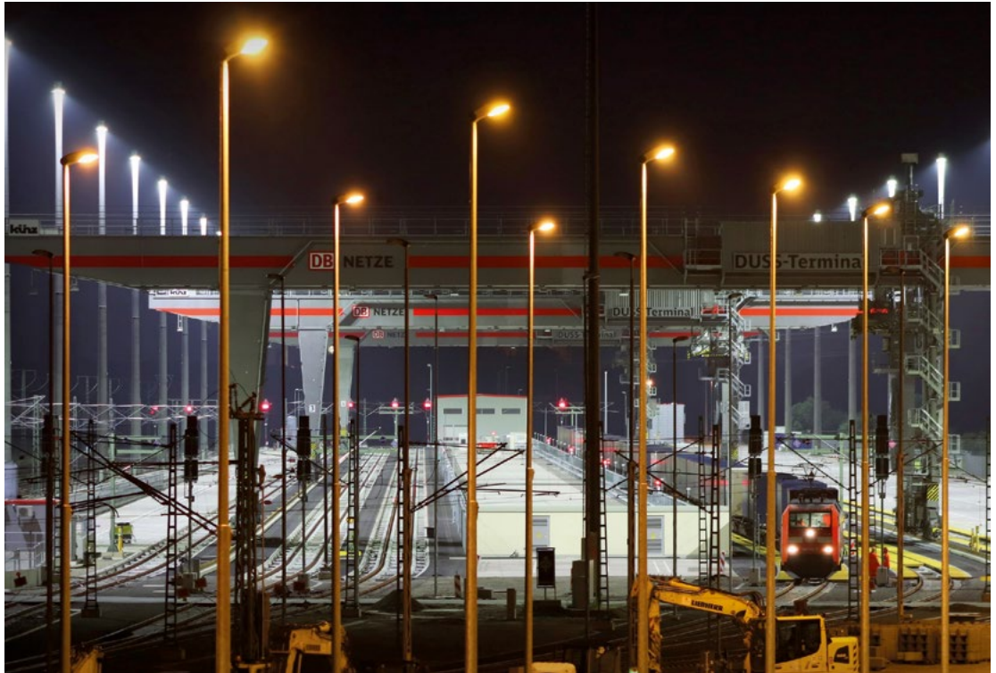
Abbildung 3: Ein KV-Zug verlässt die Anlage nach Osten. Zur Reduzierung der Lichtimmissionen strahlen die Hochmastleuchten nur den Umschlagbereich aus und vermeiden Streulicht.
