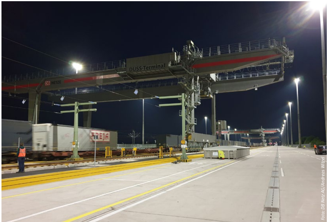
Abbildung 1: Ostkopf mit Spitzenüberspannung, Bremsprobegeräte, Leckagewanne und Portalkran bei Schwungeinfahrt mit Nachbeleuchtung.
