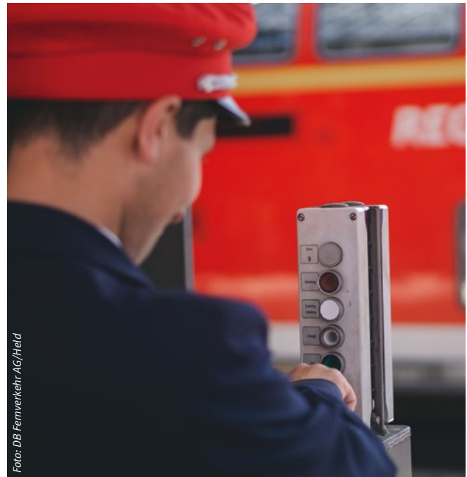
Nutzung stationäre Bedienstelle durch öA in Frankfurt (Main) Hbf.
